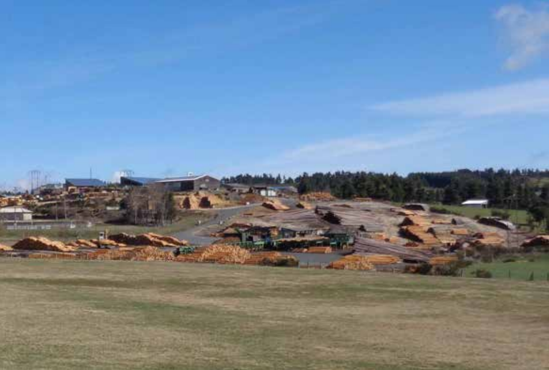
Une filière bois locale dynamique - La scierie d'Aumont-Aubrac ↑
