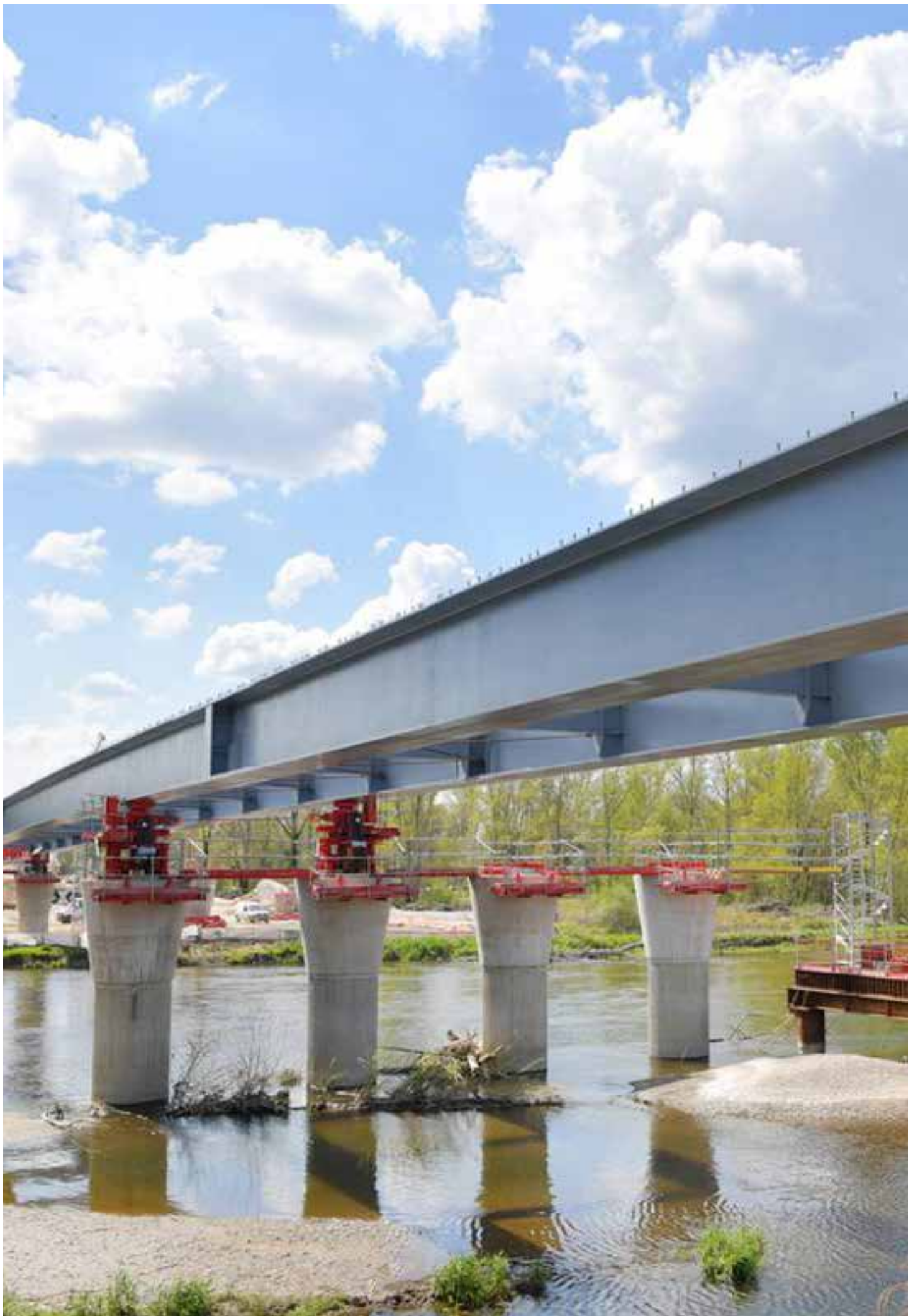
Infrastructure en construction pour la traversée de la rivière Allier par la future autoroute A79. © DR
