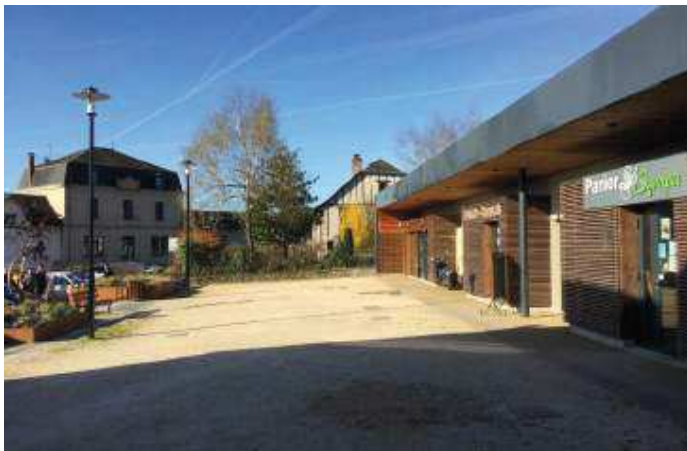
Chamboulive : nouveaux commerces en centre-bourg, à proximité des équipements
