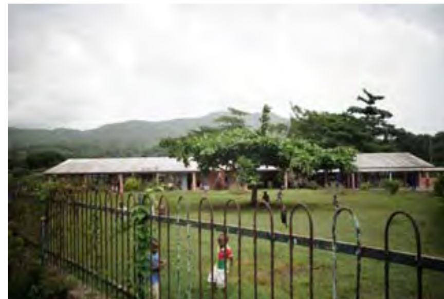
École maternelle à Dembeni, située aux franges de la ville © Obras
